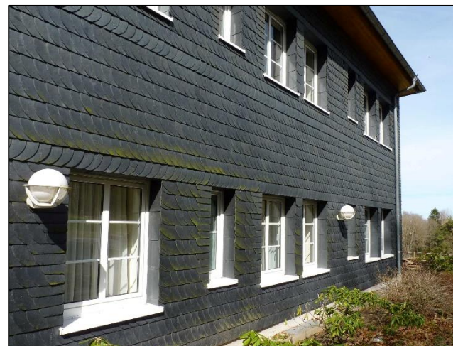
Abbildung 3: Mit Schindeln verkleideter Gebäudeteil.
