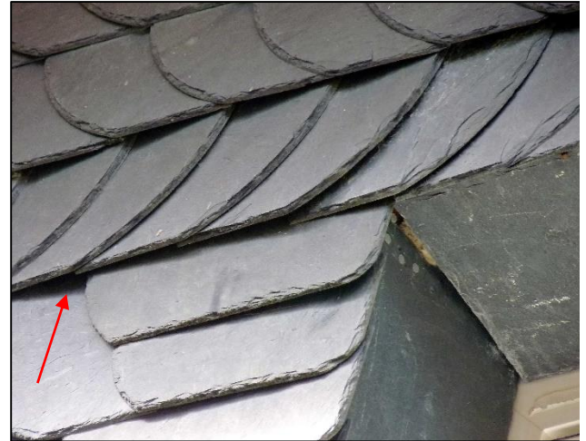
Abbildung 5: Spaltenraum in der Schindel-Verkleidung.
