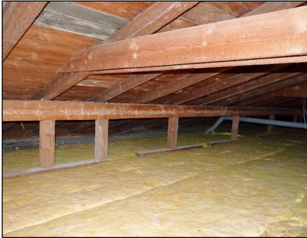
Abbildung 14: Teilansicht der Gebälkkonstruktion. Auf dem Deckenboden gelbe Dämmbahnen.
