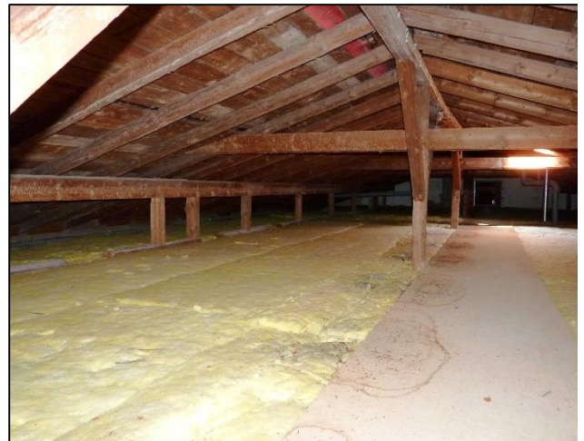
Abbildung 13: Der Dachboden über dem Zentralflügel.
