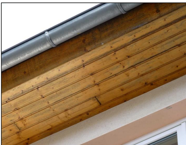
Abbildung 6: Der Dachüberstand ist größtenteils kompakt und spaltenfrei mit Profilbrettern verkleidet.
