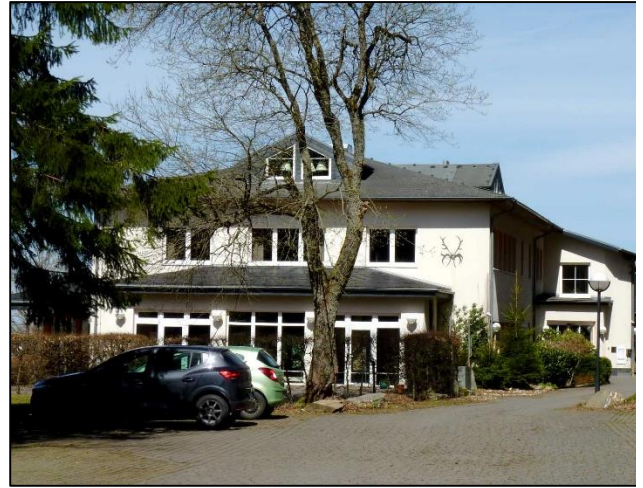
Abbildung 19: Ansicht des Südflügels von Süden.
