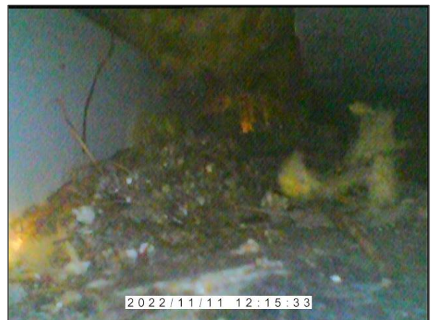
Abbildung 4: Blick in den Schindel-Spaltenraum.
