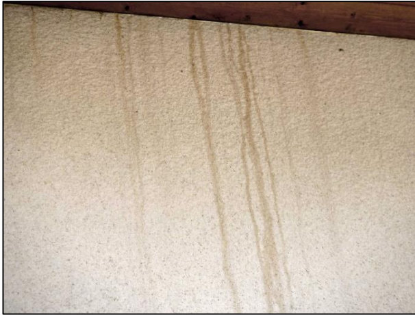
Abbildung 5: Vermeintliche „Urinstreifen“ auf dem Putz, Aufnahme vom 12.04.2022.
