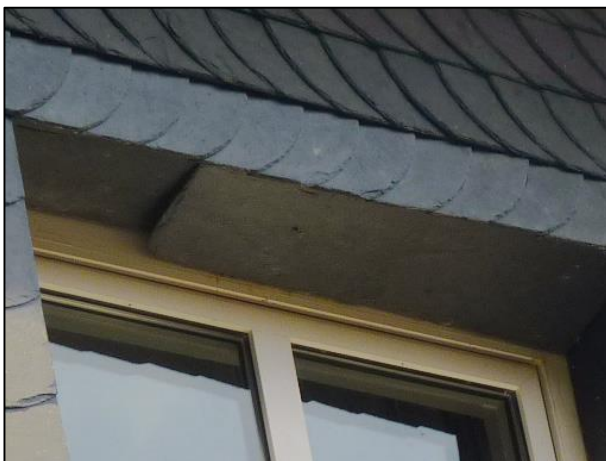
Abbildung 3: Abstehende Schindel über dem rechten Fenster.
