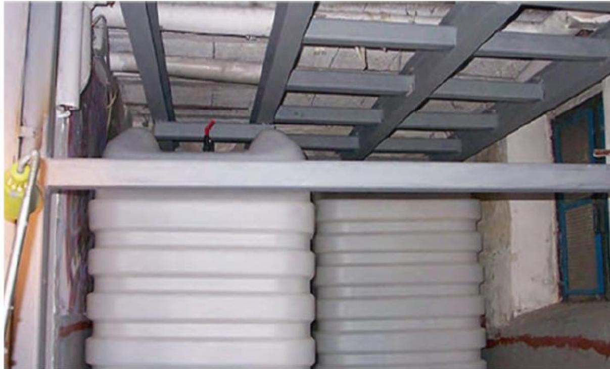
Gegen Auftrieb gesicherte Heizölanlage
