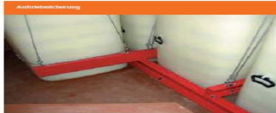
im Hinblick auf das Aufschwimmen ist der nicht gefüllte Tank. Für die Bemessung der Halterungen gegenüber Auftrieb ist daher vom leeren Tank auszugehen; dies gilt auch für Außentanks.
